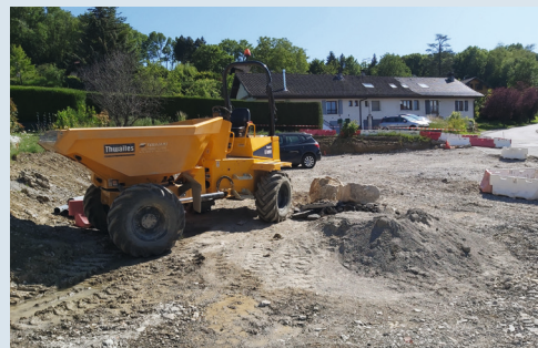
Le chantier du Mely à Blécheins
