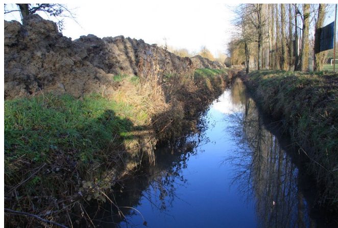
Recalibrage d'un cours d'eau
